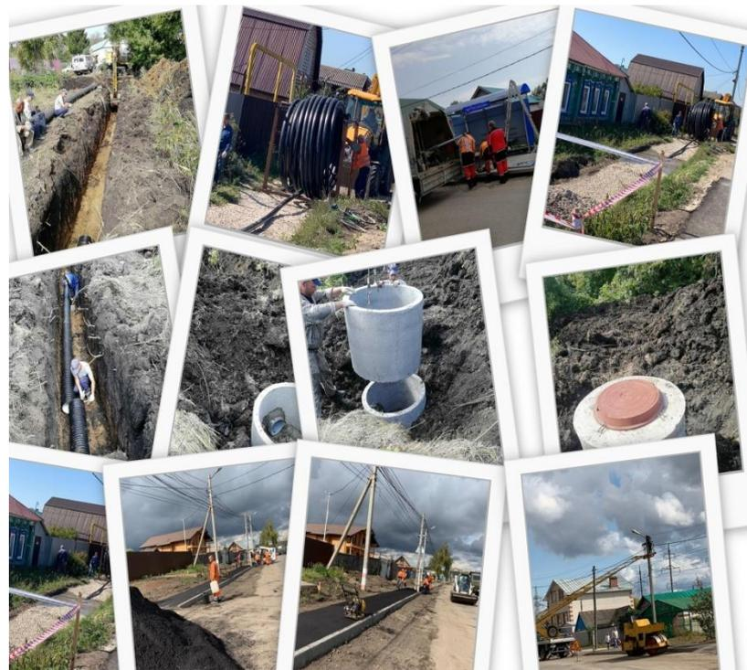
**В рамках проекта «Сухая и Безопасная Мостовая» в ТОС проведены работы по расширению проезжей части ул.Звездная, появились 800 метров бордюров и новые тротуары общей длиной 700 метров, водопровод длиной 250 метров, 1 опора и 4 фонаря уличного освещения и ливневая канализация длиной 300 метров**
